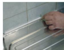
Lisser le joint en tirant dans le sens du joint à réaliser. Toujours tenir l'outil en oblique afin de réussir le croisement des joints.
